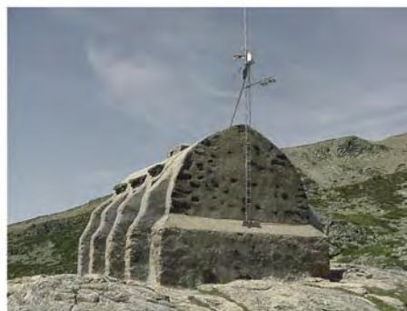
Estación del Refugio Zabala
