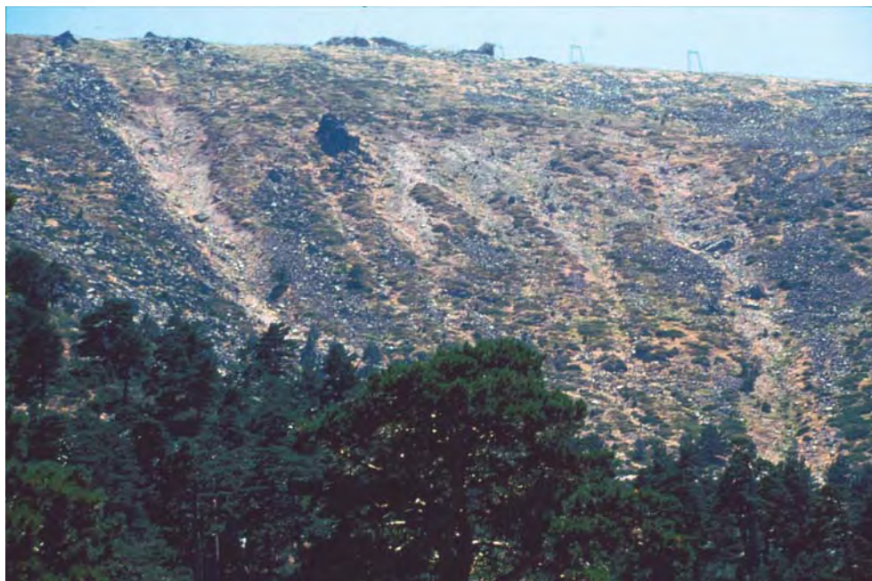
Figura 9. Regueros debidos a la incisión por aguas nivo-pluviales en la cabecera de Arroyoseco y Arroyofrío, ya fuera del dominio del Valle.
