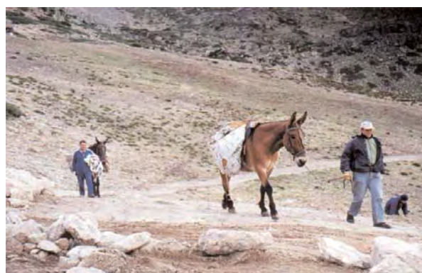
Escombros y materiales pequeños se retiraron con mulas.
