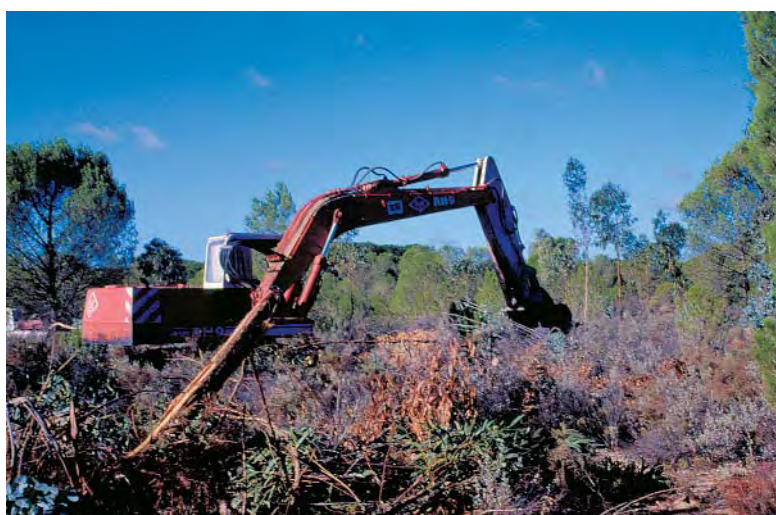
Figura 2. Trabajos de arranque de tocones de eucalipto
