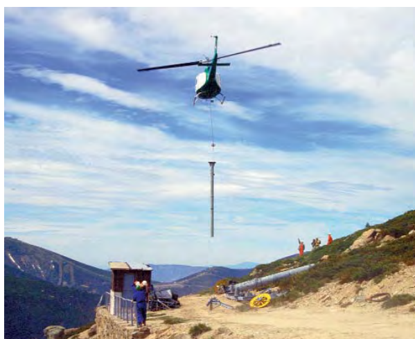
Para la retirada de elementos pesados se emplearon medios aéreos y así no ocasionar mayores impactos.
