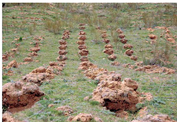
Foto 2: Ejecución de proyectos de reforestación en laderas con pendientes entre el 40 y el 60 % y litologías fácilmente erosionables (arcosas). Torredondo (Segovia). Detalle.
