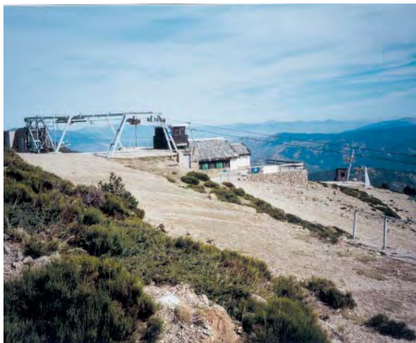
Núcleo de la estación en la morrena meridional del circo glaciar. Las infraestructuras provocan un fuerte impacto paisajístico y alteraciones en la geomorfología glaciar.
