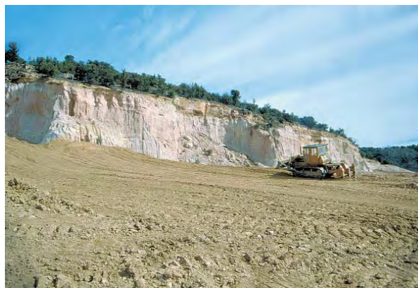
Foto 5. Extendido de depósitos coluvionares sobre la superficie del glacis, reconstruyendo una estructura de ladera similar a la original (ver figura 2). El empleo de maquinaria pesada en el movimiento de las formaciones superficiales obligó a una posterior descompactación de la superficie reconstruida.
