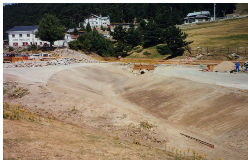
Reapertura del cauce del arroyo de Los Cotos en el aparcamiento
