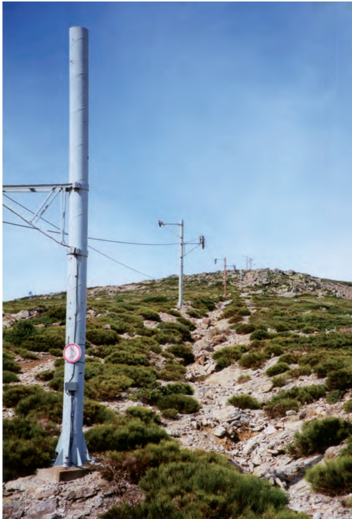
1997 Pilonas del telesquí Dos Hermanas. Cárcava.
