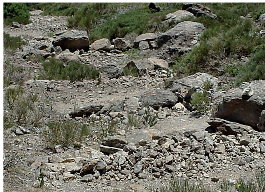
Trabajos de consolidación en cárcavas del remonte de Dos Hermanas
