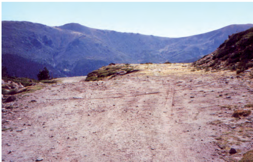
Desmonte en la morrena (pista para vehículos)
