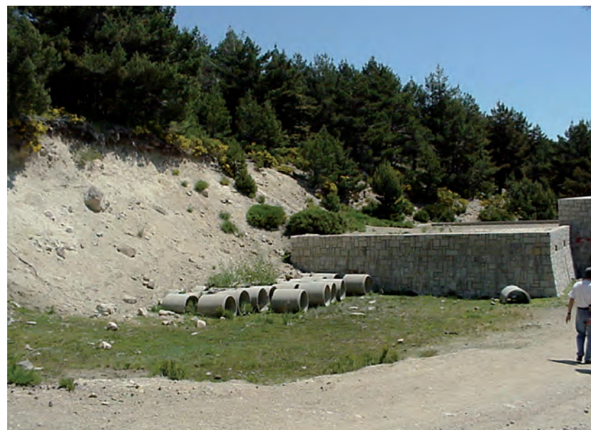
Depósito de agua
