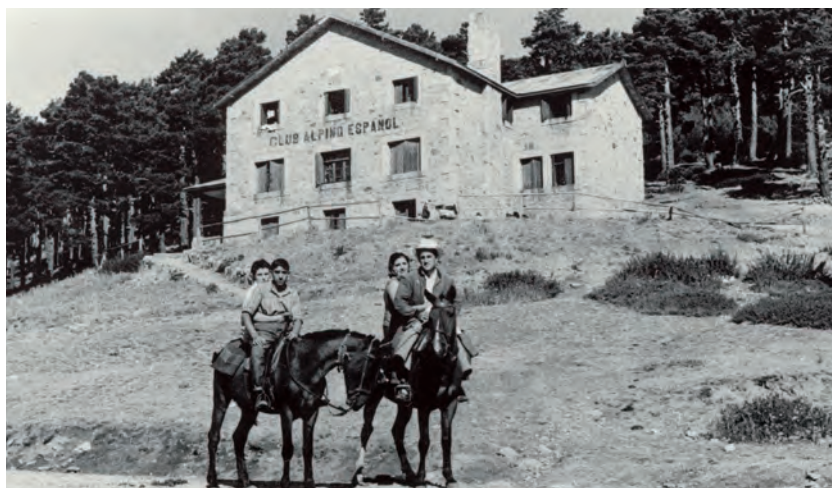
Puerto de Los Cotos con el Club Alpino ya construido.
