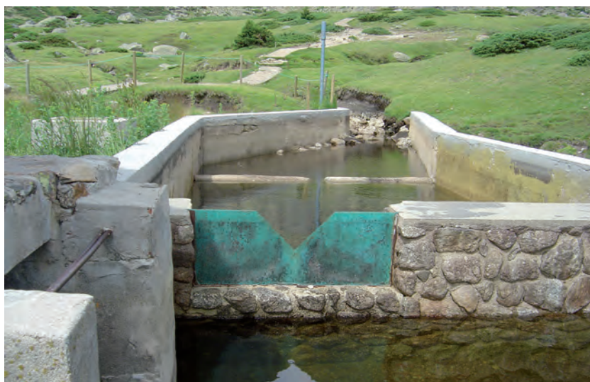
Estación de aforos en el arroyo de la Laguna de Peñalara
