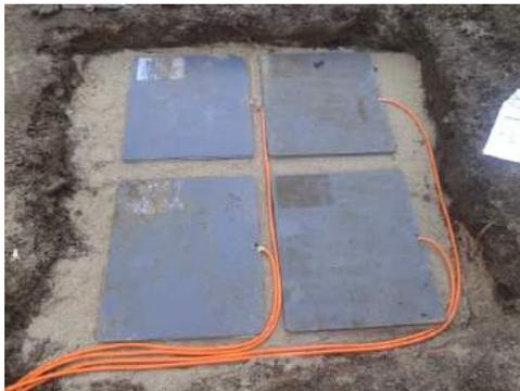
Imagen 6: Instalación de aforador de losa acústica bidireccional
